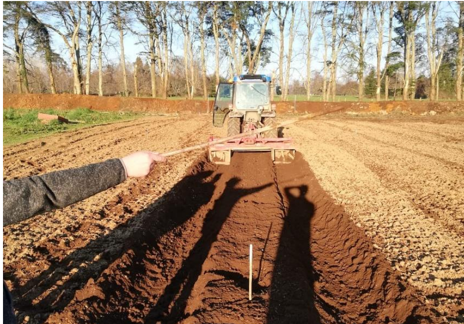
Rotovator en trabajo de construcción del camellón.
